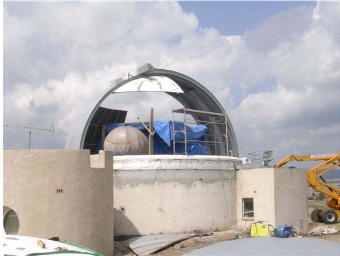
Réfection de la coupole
