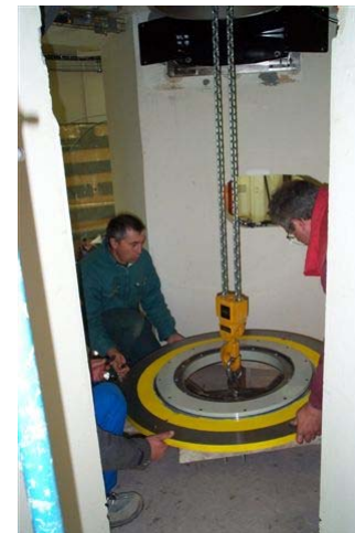
Montage disque frein azimut
